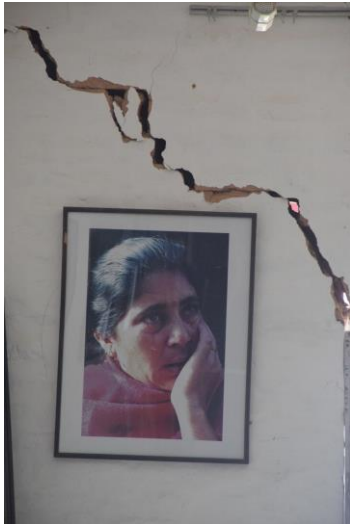
ひび割れした展示室
